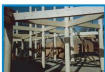
Kurzbeschreibung: Die Bauwerke sind alle in Massiv- und Holzbauweise mit EG und OG erstellt. Die Lastabtragung der Decken und Dächer erfolgt jeweils über Mauerwerkswände + Stahlbetonstützen und teils auch über Holz-Ständerwände und Holz-+ Stahlstützen. Die Gründung erfolgt jeweils mit Einzel- und Streifenfundamenten. Die einzelnen Bauwerke werden über die
